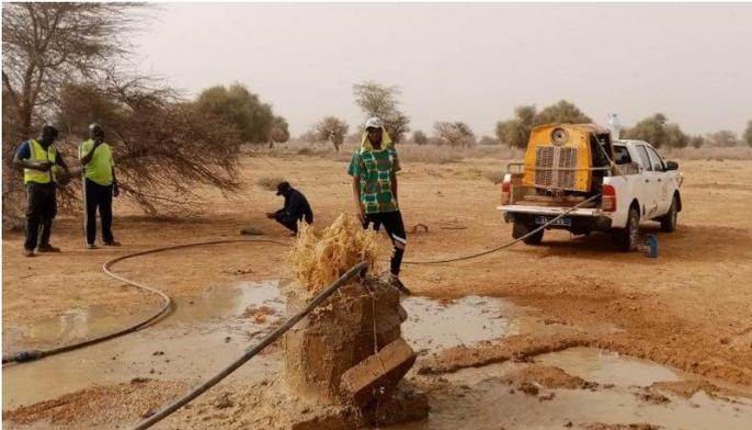
*Test de débit du forage avec Groupe Electrogène*
