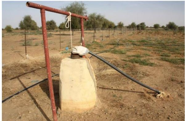
*Le forage : 50 m de profondeur – 20 m<sup>3</sup> /h*
