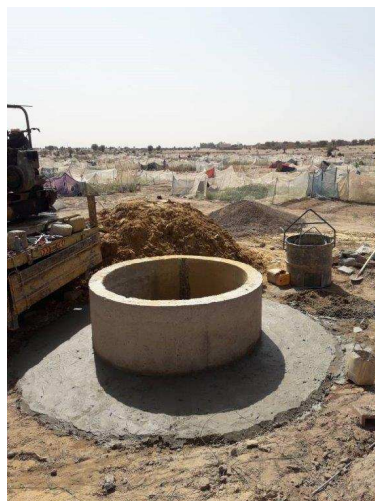
Le puits n°2 est terminé
