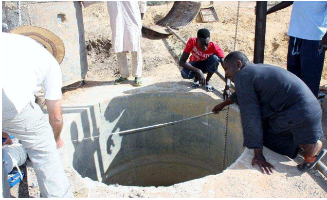
Novembre 2017 : suivi par le CERADS du fonçage du puits n°1
