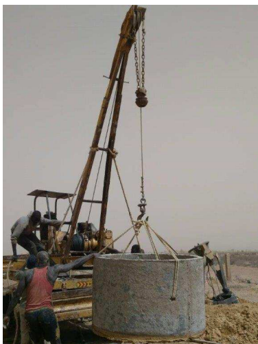
Phase 2 des fonçages des puits avec le matériel lourd d'Hydraulique Rural
