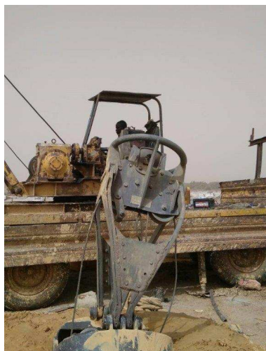
Phase 2 des fonçages des puits avec le matériel lourd d'Hydraulique Rural
